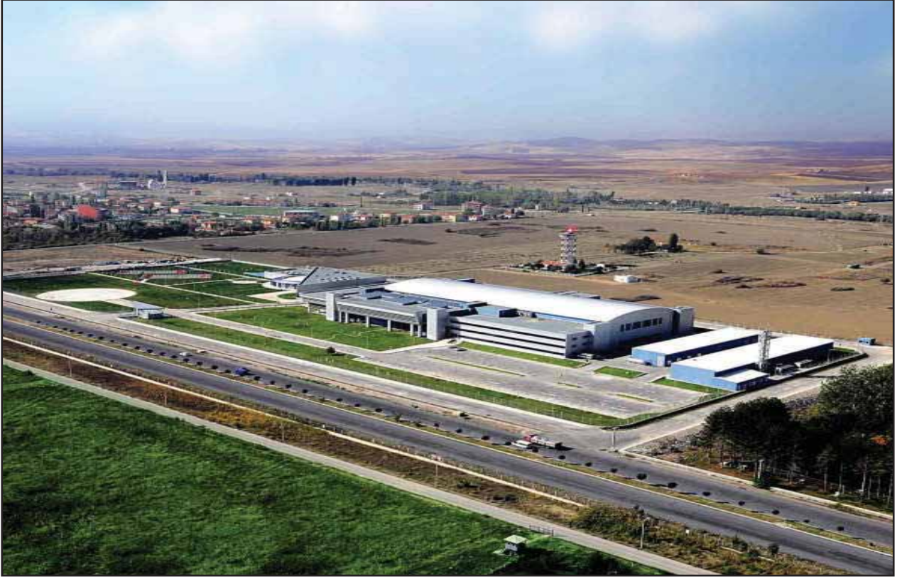
Resim-1.2. DHMİ Esenboğa Havalimanı SMART Binası (Kaynak; DHMİ)
