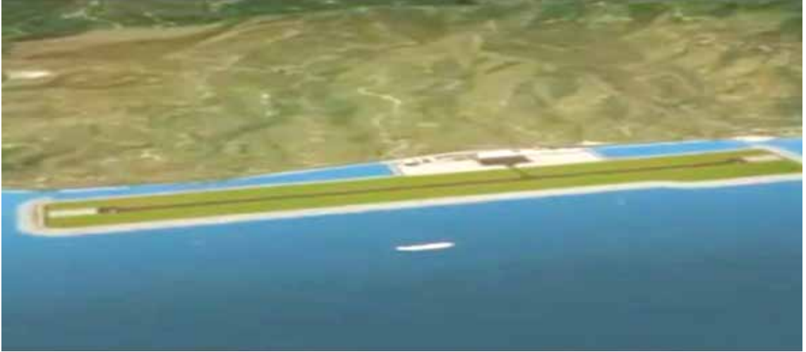
Resim-6.3: Ordu-Giresun Havalimanı inşaatı tamamlandığındaki genel görünüm (© UDHB, Altyapı Yatırımları Genel Müdürlüğü)
