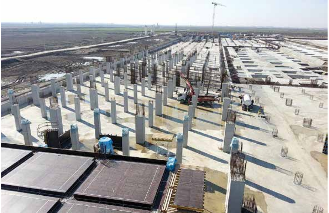
Resim:6-4: Adana, Çukurova Havalimanı inşaatından görünüm, Aralık 2013 (© Koçoğlu Grubu)
